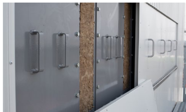
Manutenzione più facile grazie alle entrate laterali nel silo minerale caldo (secondo DIN EN 536)
